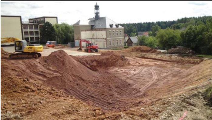
Massiver Technikeinsatz am Standort für den Schulneubau
